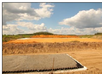
Рисунок 9. Геоячейки «ПРУДОН-494» для объемного армирования грунтов
